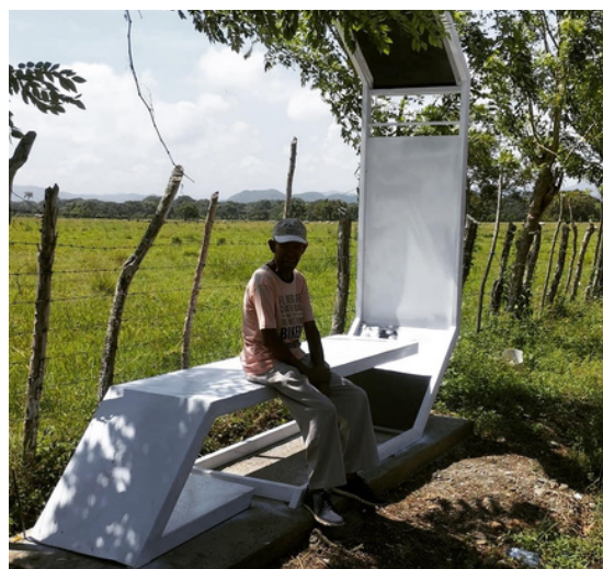
Carretera Fantino - Sierra Prieta; trabajo en proceso.
