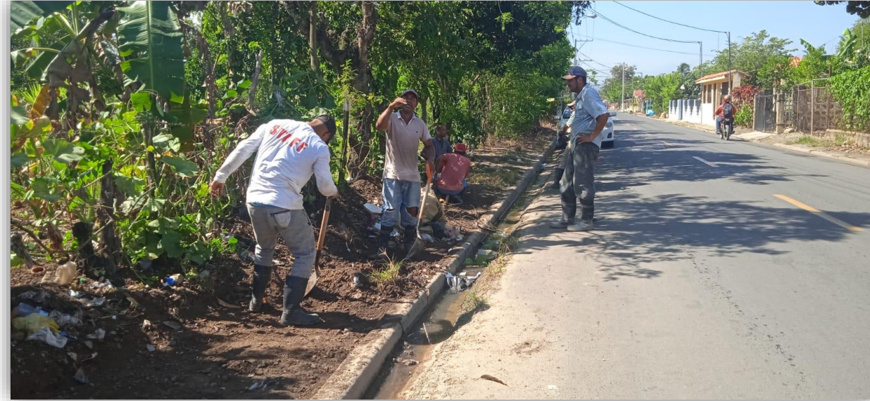
Construcción de aceras en la calle Paco Saviñón
